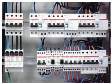
Вариант применения наконечников с манжетами. В левой части – подключение вводного автоматического выключателя (вверху) и ограничителя напряжений «АВВ» (внизу).
